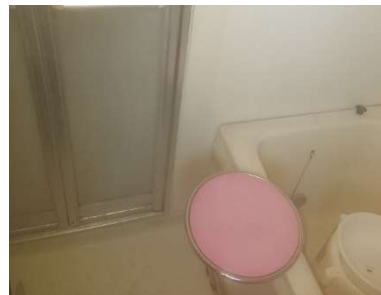
浴室 リフト施工前
