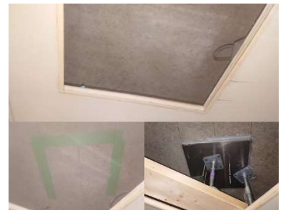
天井裏 施工前/中
