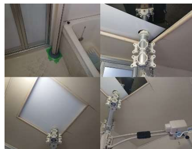
リフト施工後
