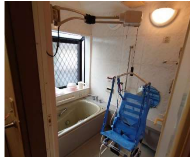
リフト施工後
