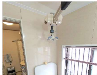
リフト施工後 - 1
