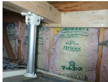
天井裏取付部
