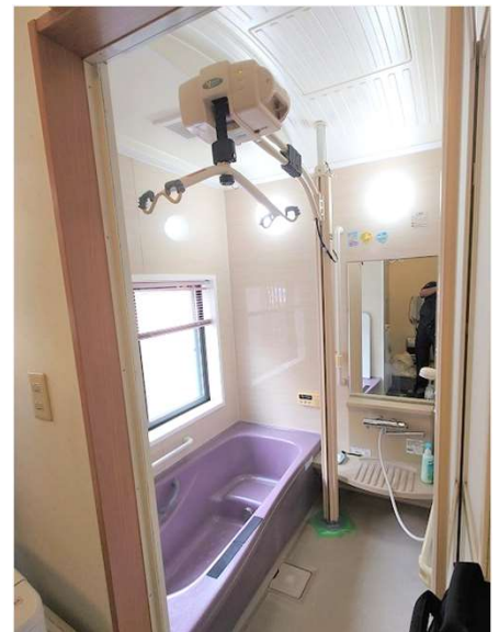
リフト施工後 - 2
