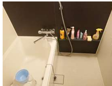
浴室リフト 施工前
