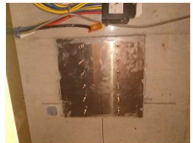
スラブ接着プレート取付
