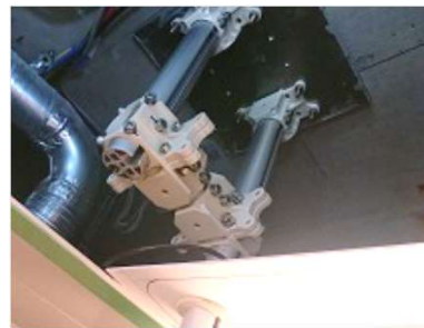
取付部材 施工後
