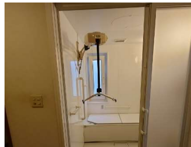
リフト施工後
