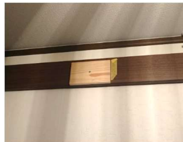
リフト上部取付補強
