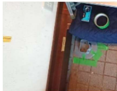
土間へコムフーツ取付
