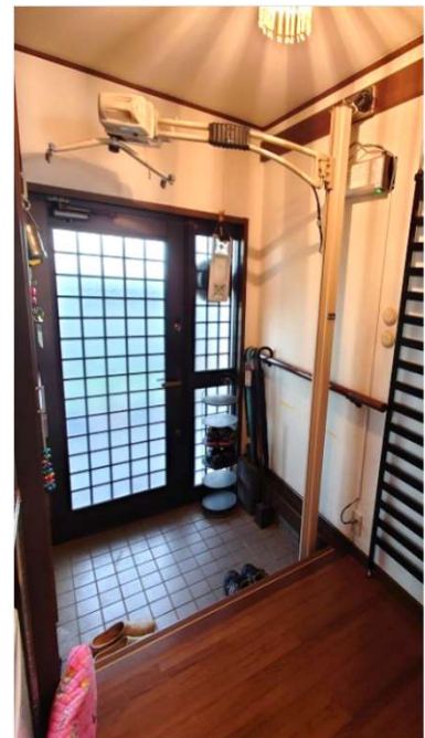
リフト 施工後
